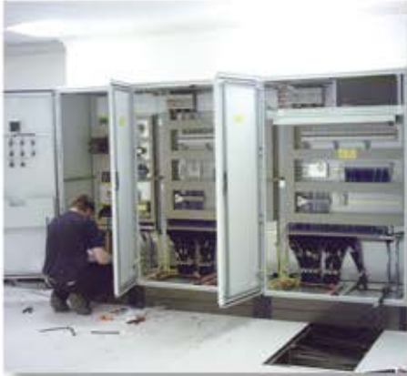
Installation von Schaltschränken Control Cabinet Installation
